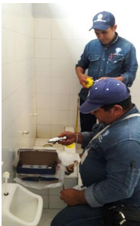
Instalación grifería escuela Buenos Aires
