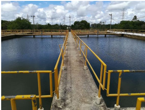
Planta de Tratamiento Aguas de Barrancabermeja
