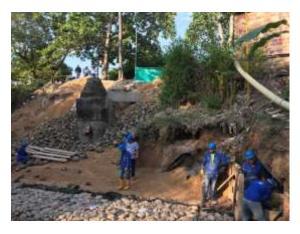
La empresa Aguas de Barrancabermeja realiza obras de construcción de alcantarillado pluvial en la carrera 64 entre calles 47 y 47 A del barrio Nueve de Abril; allí fueron instaladas tuberías de 20 y 24 pulgadas para aumentar la capacidad hidráulica en el manejo de las aguas lluvias del sector y así evitar que se sigan presentando inundaciones sobre las vías durante la temporada invernal.
