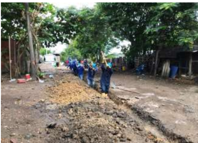
Nueve son los barrios en los que se están realizando las obras, en el Progreso, Castillo y Ramaral, ya culminaron.
