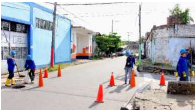
Este mantenimiento se realizará en todas las Comunas del Puerto Petrolero.
