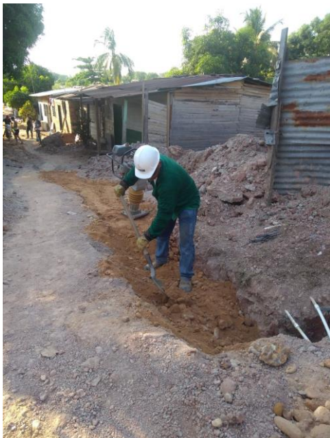
Aguas de Barrancabermeja, realizó obras de alcantarillado sanitario en la calle 75 del barrio Jerusalén.
