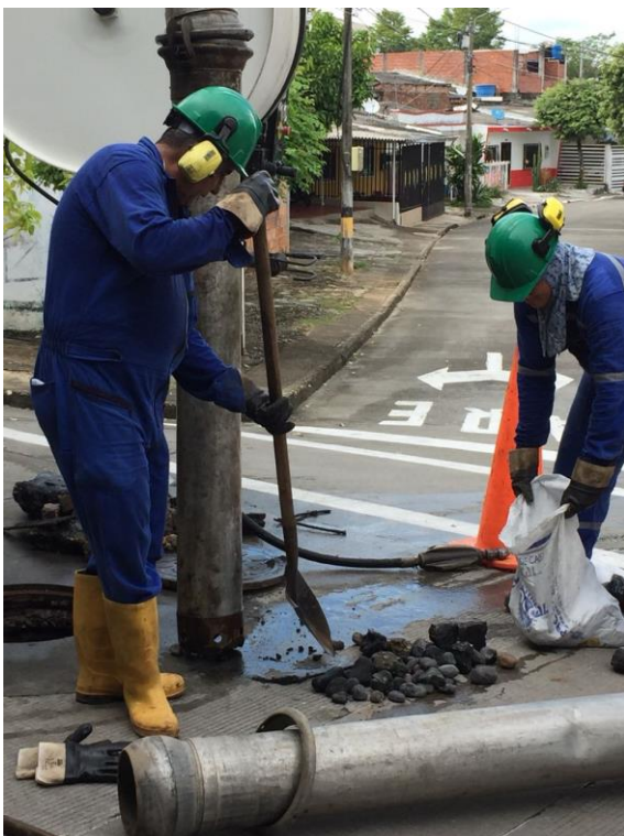
Material utilizado para la construcción fue lo que se encontró en el sistema de alcantarillado del barrio Primero de Mayo
