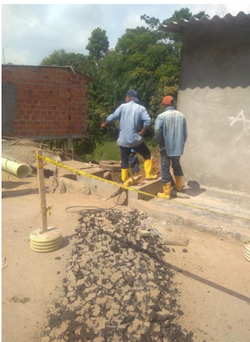
12 metros de tubería de PVC, para alcantarillado sanitario están siendo instalados en la calle 37 del barrio Villa de Leyva
